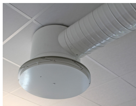
Synligt montage av det aktiva tilluftsdonet TTC med donlåda HTR.
