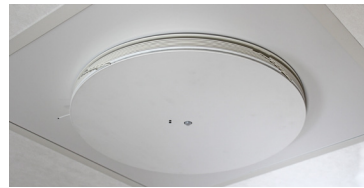
TTC-250 monterat i donlåda med undertaksplåt UTD i undertak.
